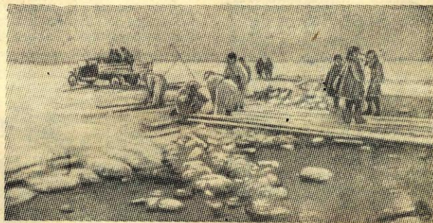
Быстро наводили дорожники мосты через трещины во льду Ладожского озера, не допуская заминок в движении машин
